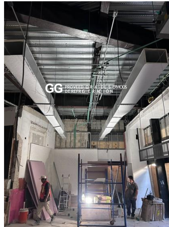
Instalación de Equipo tipo Fand and Coil Mca. Carrier y Ductería
